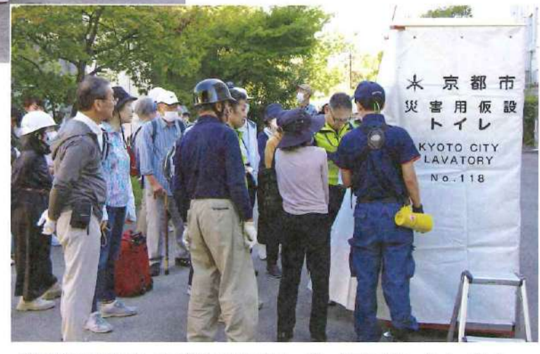
駐車場に設置した災害用仮設トイレ（マンホールトイレ）
